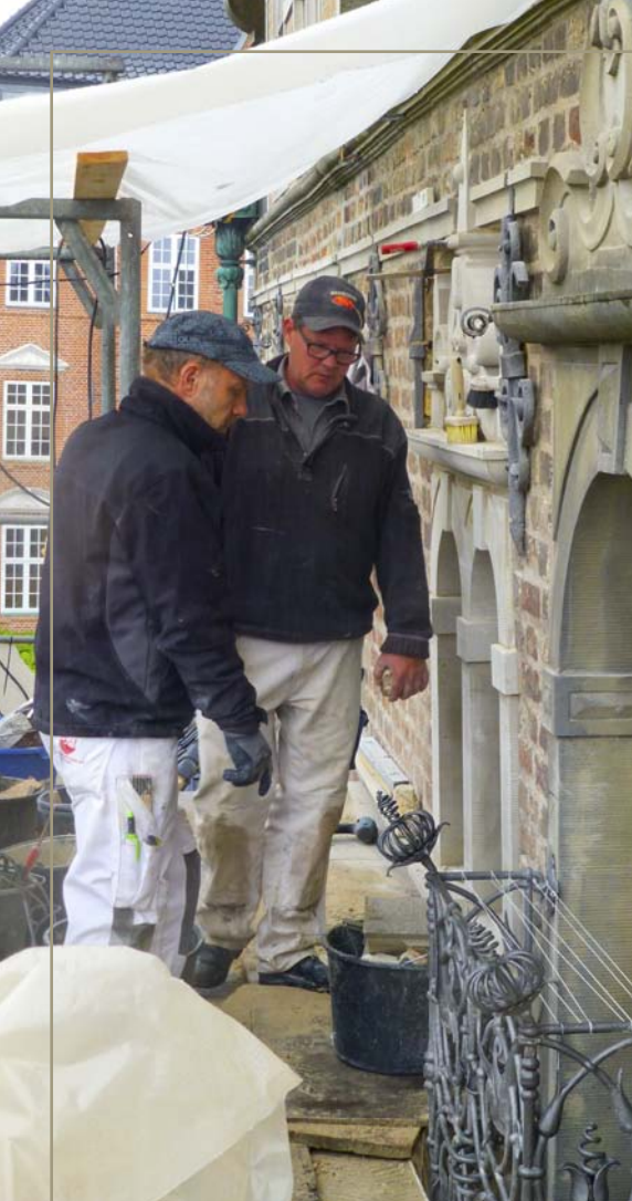
Udskiftningen af sandsten blev indledt i 2012, og stenhuggermester Jan Hemmsen (øverst til højre) er i gang med at udhugge ny sten, der bliver muret ind i 2015
